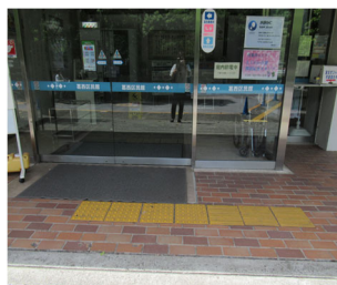
葛西区民館入口
