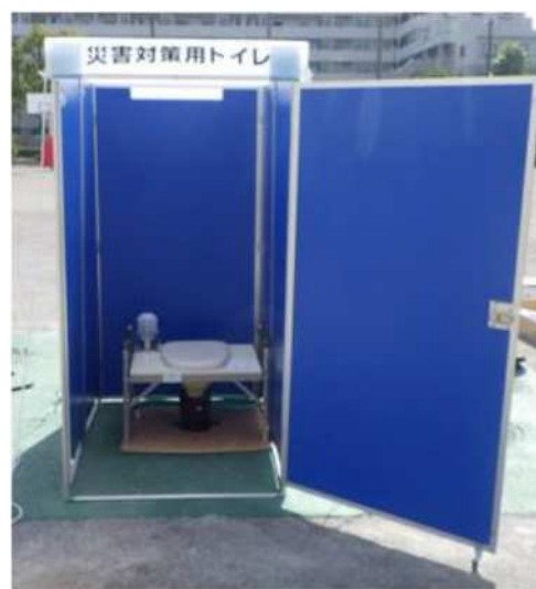
図5.2 マンホールトイレ
