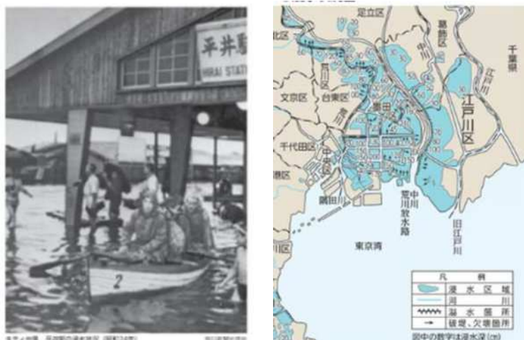
図 4.4 平井駅の浸水状況（左） 浸水状況図（右）
