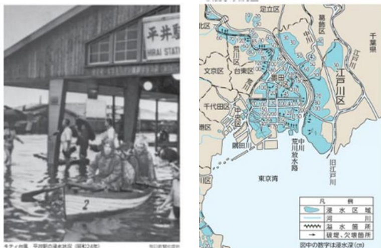
図 4.4 平井駅の浸水状況（左） 浸水状況図（右）
