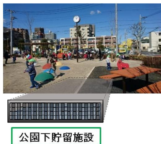
図 5.7 公園下貯留施設
