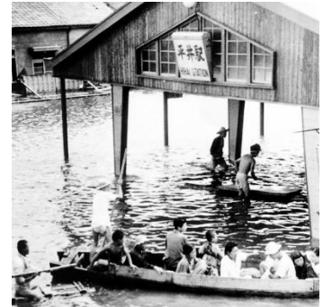
キティ台風による被害(平井駅)
