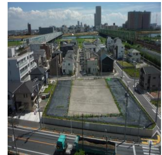
整備が完了した高規格堤防 (北小岩一丁目)
