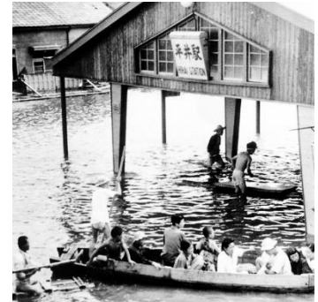
キティ台風による被害(平井駅)
