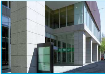
西側ピロティ
