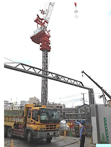
《工事現場の様子》
