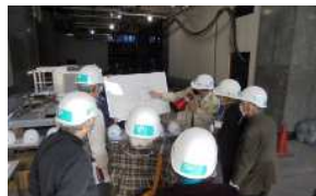
1階 住宅駐車場出入口付近
