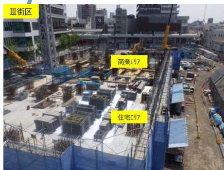
2024年5月時点の工事ヤード内の様子
