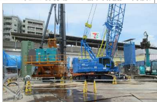
街区工事の様子
