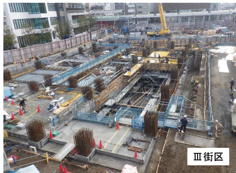
2024年2月時点の工事ヤード内の様子 (Ⅲ街区)
