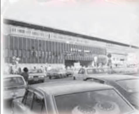
S47 複々線化（高架化）完成
