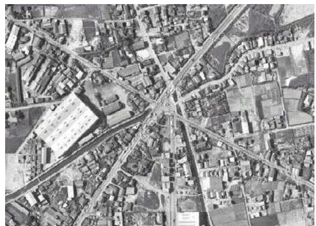
昭和38年(1963)の航空写真でみる菅原交差点南側の中井堀は水路
