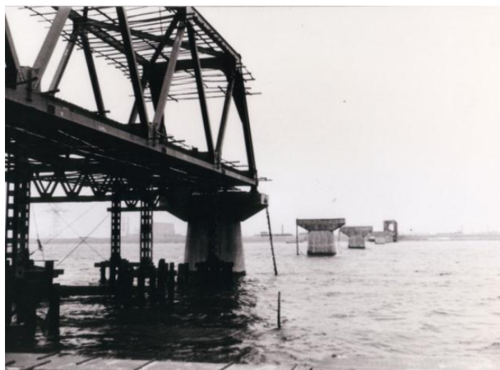
東西線の鉄橋工事(昭和39年)
