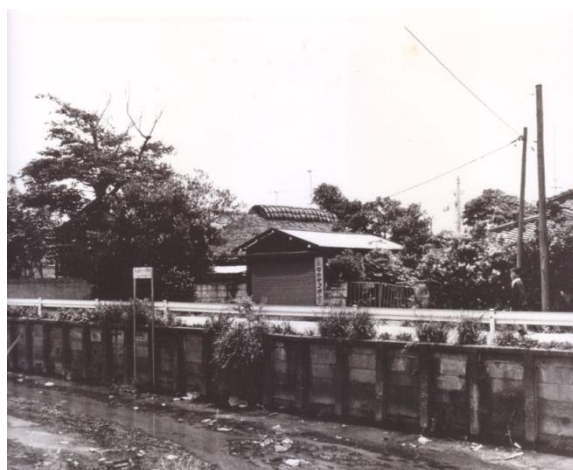
改修前の古川
