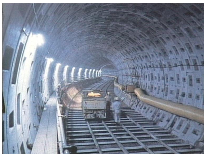
下水道の幹線工事
