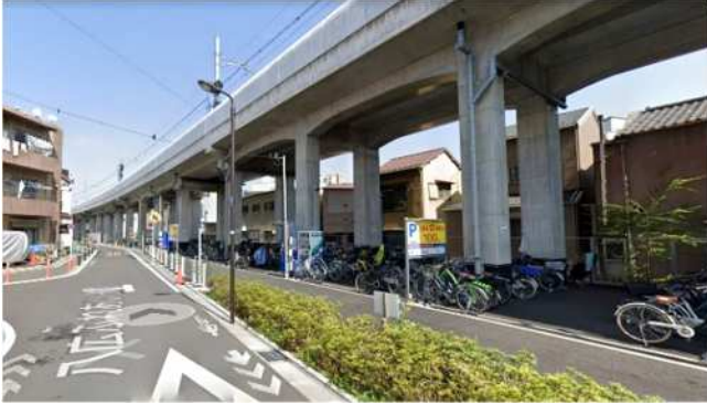
京成曳舟駅付近の高架下利用（駐輪場）
