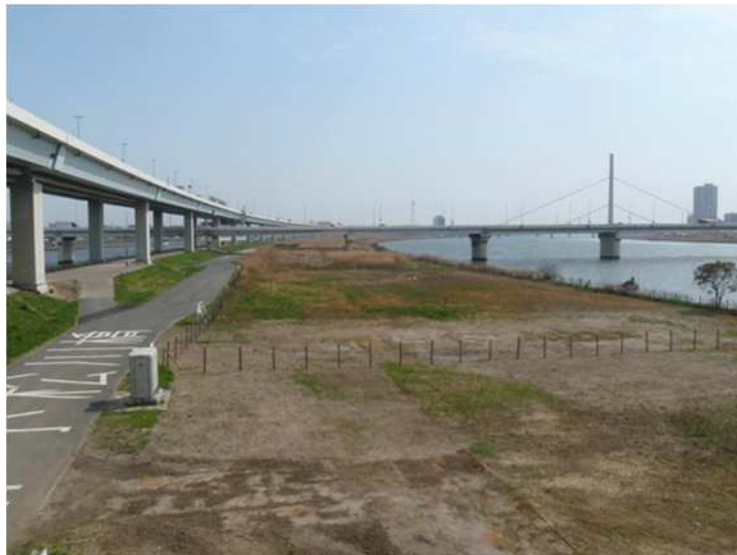
中堤（小松川橋付近）
