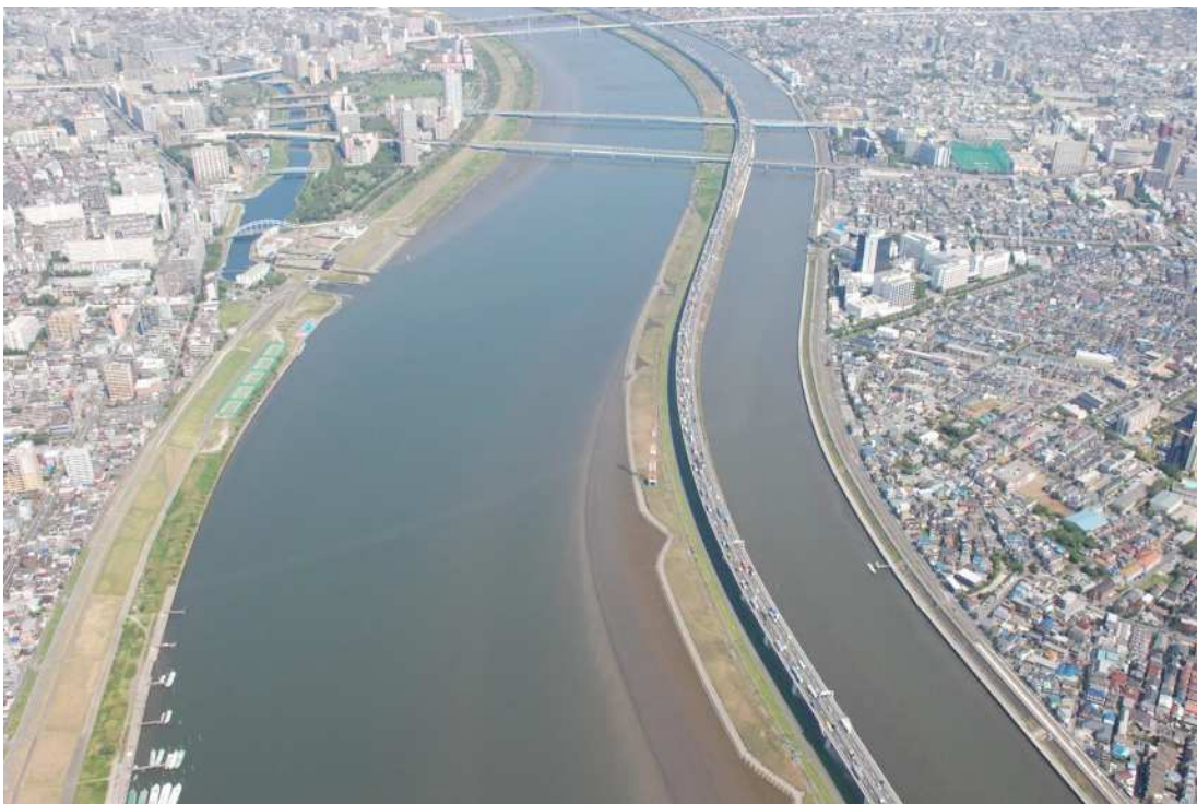
左岸中堤ブロック付近の荒川(1.5km～4.0km)
