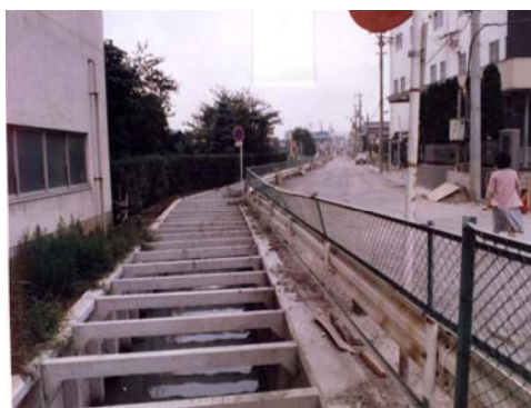
下水道整備前（平成4年頃）
