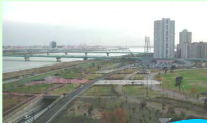
小松川地区のスーパー堤防
