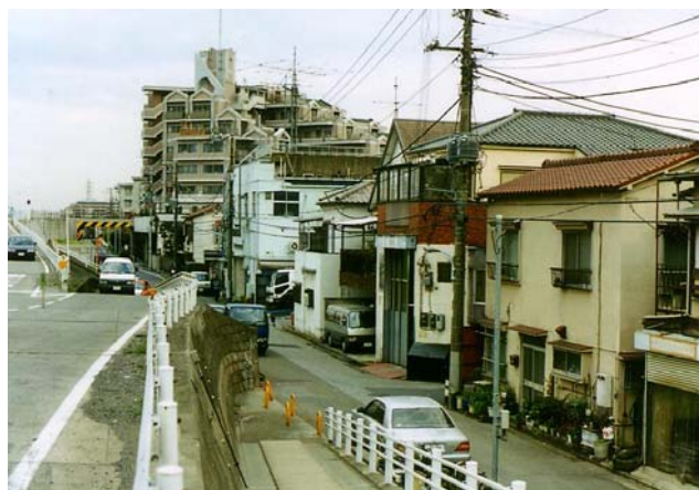
平井七丁目地区の事業実施前の状況
