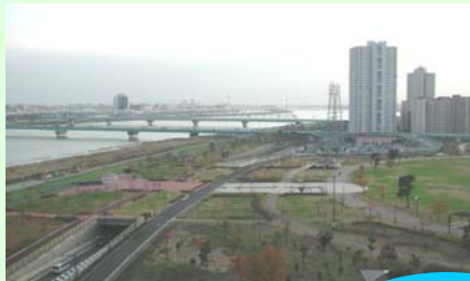
小松川地区のスーパー堤防
