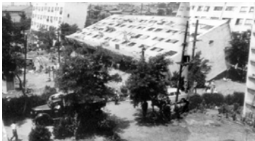
液状化による県営住宅の倒壊 新潟地震（昭和36年）
