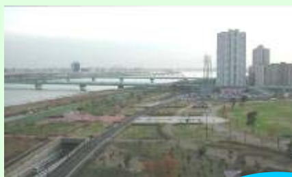
小松川地区のスーパー堤防
