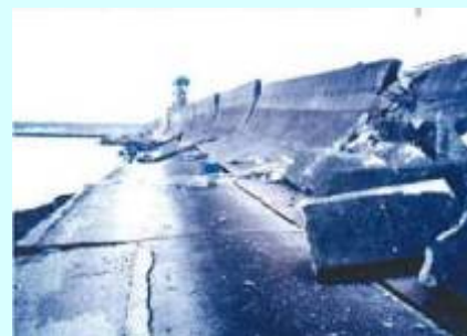
阪神・淡路大震災による淀川の堤防の崩壊 (平成7年)
