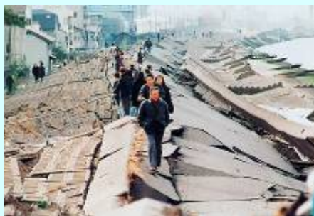
阪神・淡路大震災による淀川の堤防の崩壊 (平成7年)
