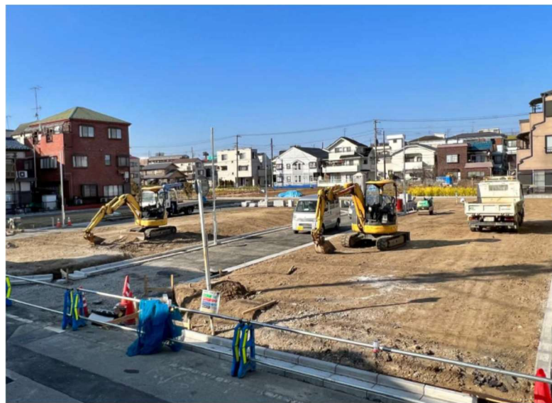
トマト工事現場 撮影 R4.2.2
