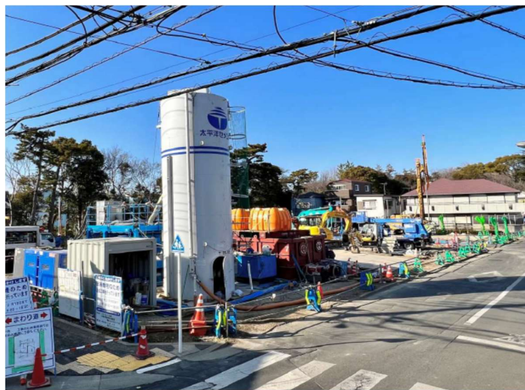
セロリ工事現場 撮影 R4.2.2
