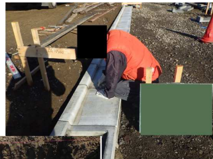
L形側溝設置
