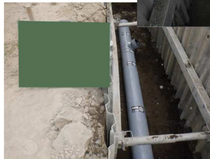
下水道整備工事(管路設置)の状況写真
