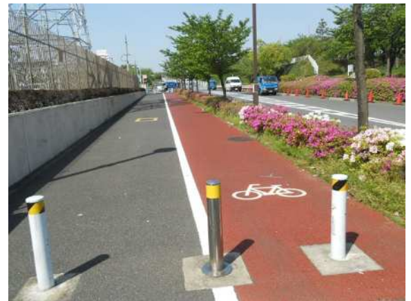
小松川地区防災再開発事業区域内
