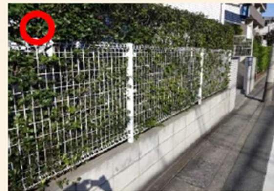
緑化したネットフェンス
