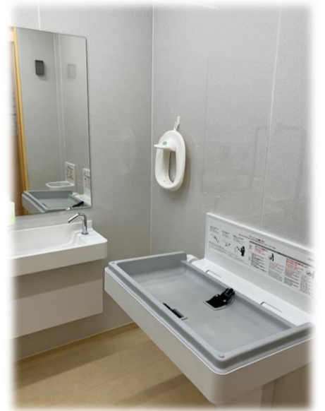
多目的トイレ
