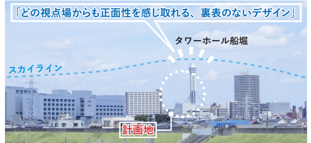
■ 船堀らしい都市のスカイライン（南西荒川より遠景）
