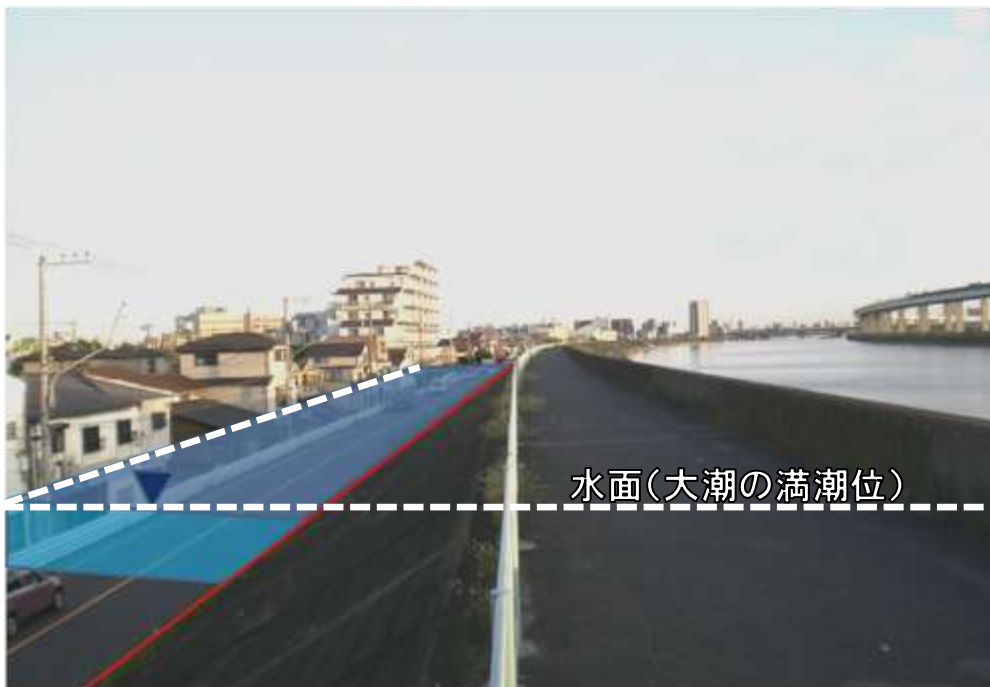
中川左岸堤防の状況
