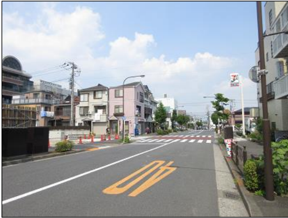
図30 電線を地中化した 補助288号線
