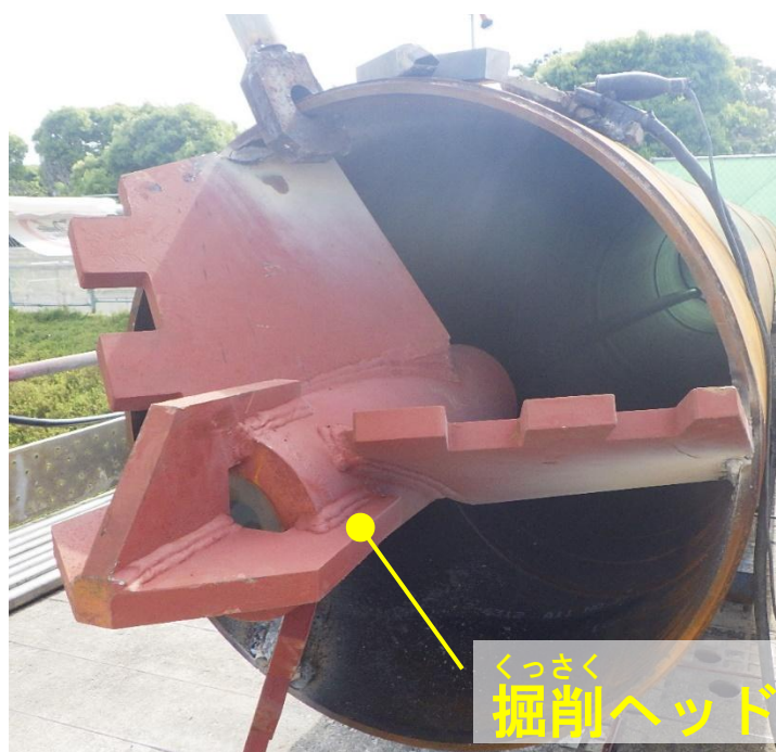
くっさく 掘削ヘッド取付状況
