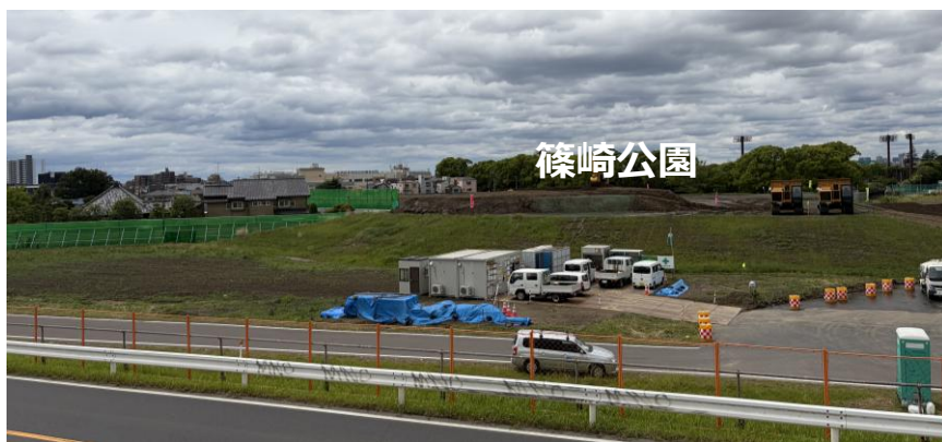
整備状況（R8.6.4堤防側から撮影）
