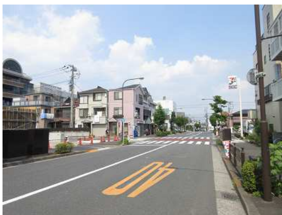
電線地中化した補助 288 号線 (鹿骨)
