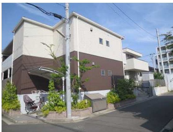
電柱を民地に建てた 戸塚駅前地区の事例
