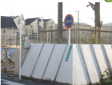
都立鹿本学園の防火水槽
