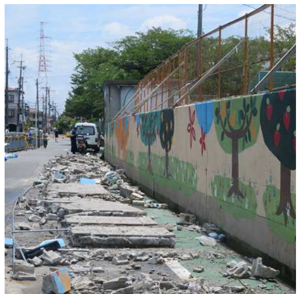
大阪府北部地震で倒壊したブロック塀
