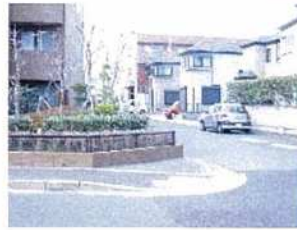
見通しの悪い交差点を改善します すみ切りを行い見通しの良くなった交差点
