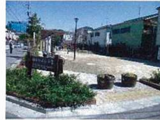
道路・公園を維持管理します
