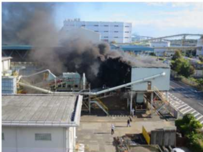
粗大ごみ破碎処理施設での火災状況
