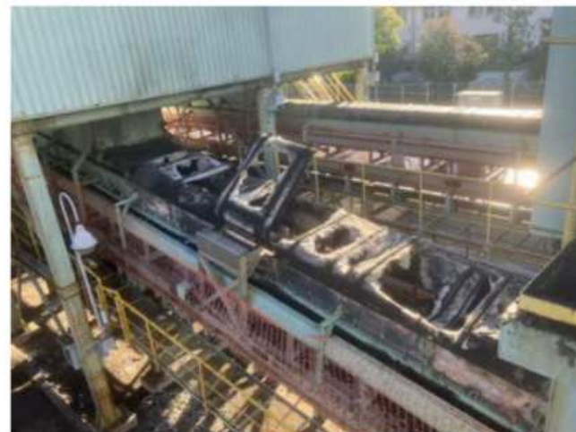
コンベヤの焼損状況
