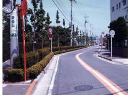
下水道整備 後
