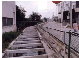
下水道整備 前
