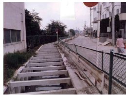
下水道整備 前
