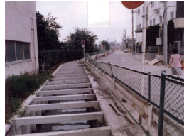
下水道整備 前
