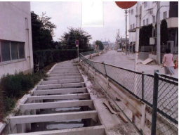
下水道整備 前
