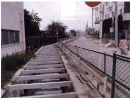
下水道整備 前
