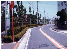
下水道整備 後
