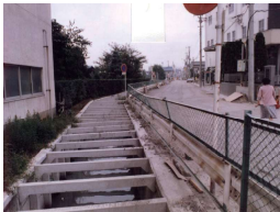
下水道整備 前
