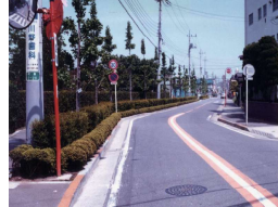
下水道整備 後
