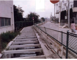
下水道整備 前
