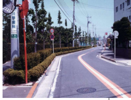
下水道整備 後
