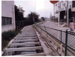
下水道整備 前
