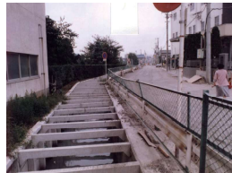
下水道整備 前
