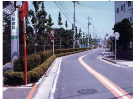
下水道整備 後
