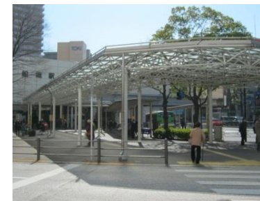
船堀駅北口シェルター
