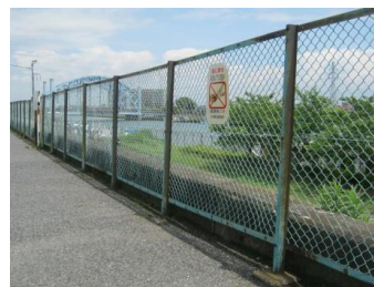
ネットフェンス
