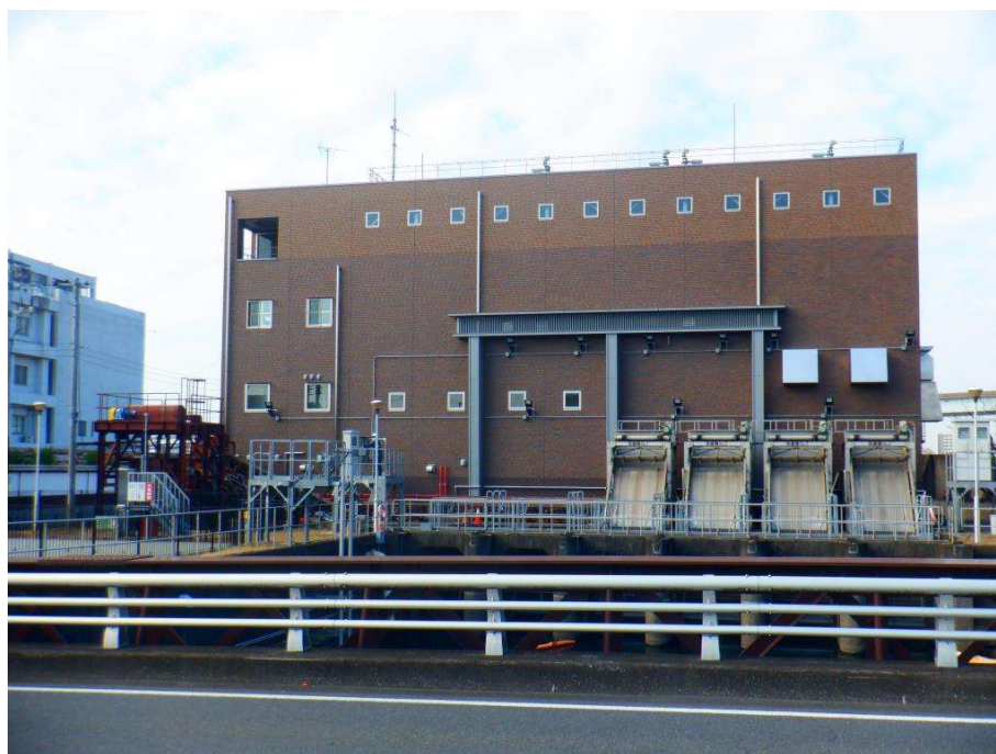
建屋（屋外東側）
