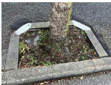
本区における根系誘導耐圧基盤材の設置パターン
