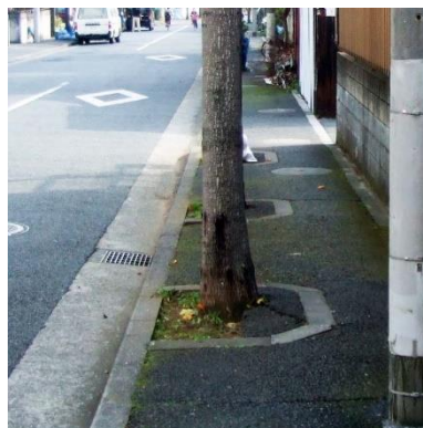
桝内アスファルト舗装
